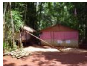
JAM が支援する Hope School の校舎。 外壁などの改修と机の寄付を行いました。
