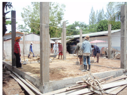
写真右： 建て替え工事の様子
