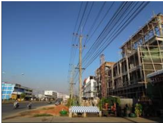
ハイウェイ沿い、建設中の建物
