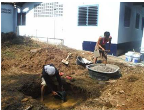
【ダイニングの基礎を掘るスタッフ】
